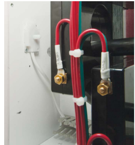
点传感器正确安装示例。
